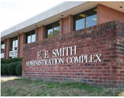
William R. Collins Bldg.
